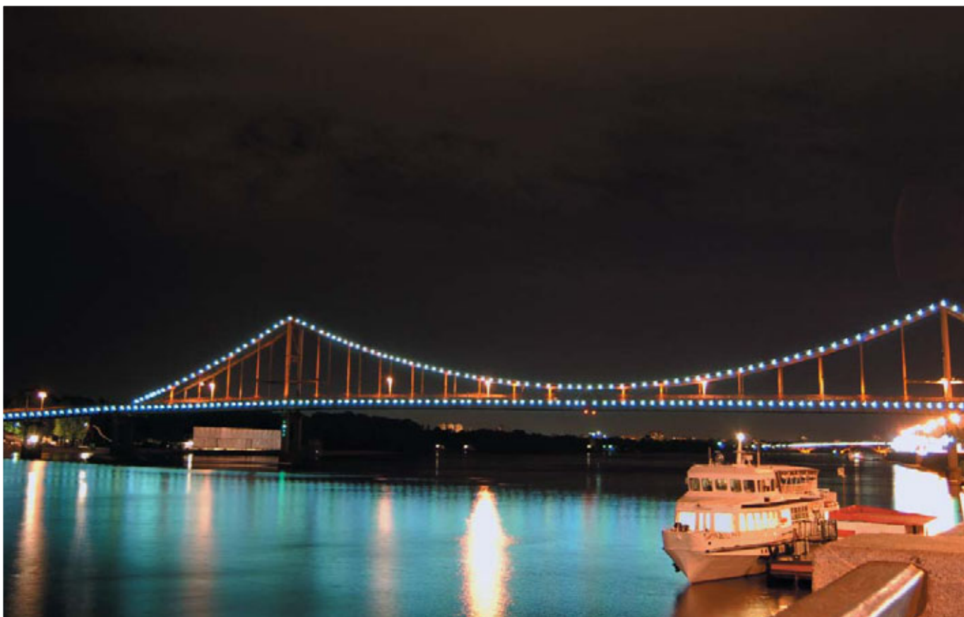
ПЕШЕХОДНЫЙ МОСТ, КИЕВ. ОСВЕЩЕНИЕ: ОТДЕЛ КОМПЛЕКСНЫХ ПРОЕКТОВ ОСВЕЩЕНИЯ И МОНТАЖА ГК «ЭЛОТЕК» (044) 206-74-42, 461-93-96
